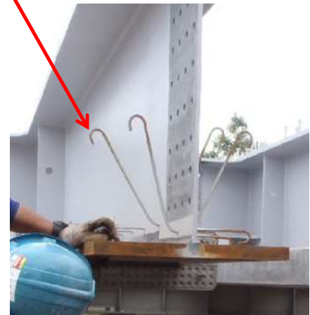
添接板取付時
