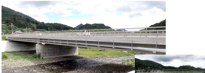
法雲寺橋（山梨県） 2022完工 2径間連続プレビーム合成桁 橋長 66.500m 桁高 1.189m～1.801m 桁高支間比 1/27～1/18
