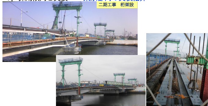
二期工事 桁架設
